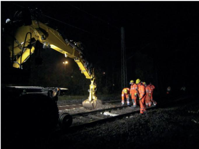
Abb. 2: Einzelschwellenwechsel: erforderliche Arbeitsbreite
