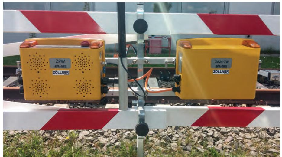
Abb. 6: Kombination aus fester Absperrung (FA) und funkgesteuerten Warnsignalgebern für Geschwindigkeiten zwischen 120 und 160 km/h im Nachbargleis, FA angeordnet auf Grenze Gefahrenbereich (links: Schweizer Electronic AG, rechts: Zöllner Signal GmbH)
