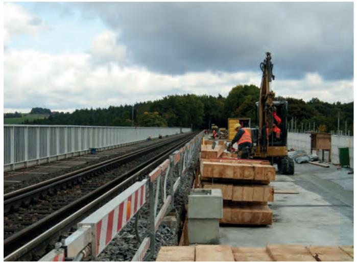
Abb. 5: Kombination aus fester Absperrung und Linienwarnsystem „Falkon“
