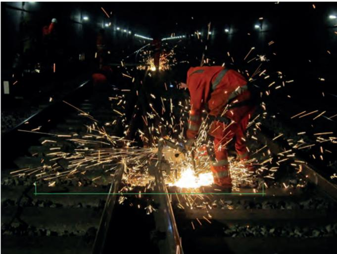
Abb. 4: Herzstückwechsel: erforderliche Arbeitsbreite
