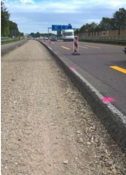
Grundhafte Erneuerung BAB A5 Gambach-Butzbach (Strassing)
